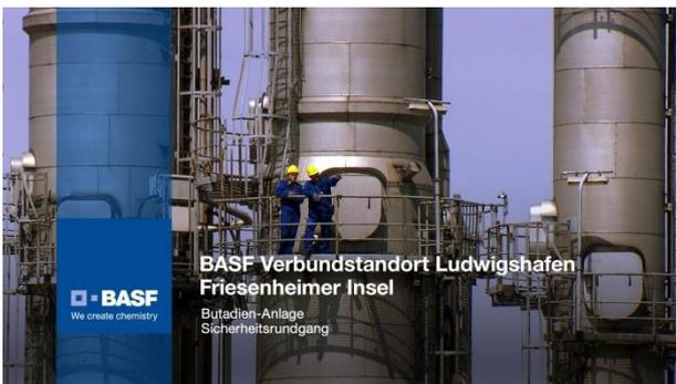
**Die Butadien-Anlage auf dem Werksteil Friesenheimer Insel des BASF Verbundstandorts Ludwigshafen produziert bis zu 105.000 Tonnen Butadien pro Jahr. Damit ist sie eine zentrale Verbundanlage, die direkt mit den beiden Steamcrackern verbunden ist.**
