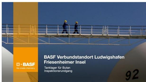
Im Werksteil Friesenheimer Insel des BASF - Verbundstandorts Ludwigshafen stehen fünf Kugeltanks, die die Produktionsanlagen mit Einsatzstoffen versorgen. Die Tanks haben zusammen etwa ein Fassungsvermögen von rund 7,5 Millionen Litern Flüssiggas. Sie werden zur Lagerung von Butangas genutzt.
